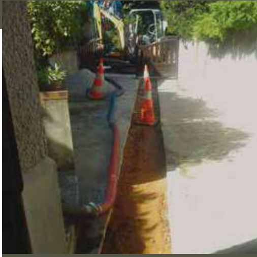
Saint-Rémy-Lès-Chevreuse Travaux de création de branchements privés Avenue Assas et Hoche
