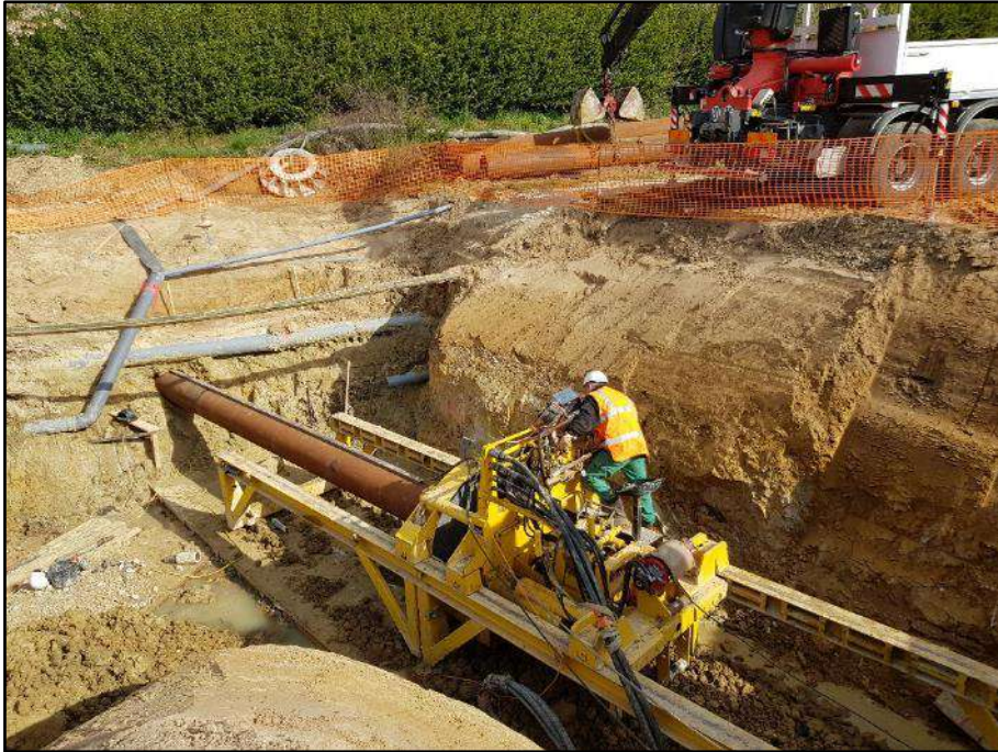
Figure 17 : Chemin de Briis à Villejust - Forage horizontal à la tarière
