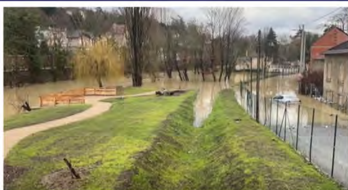
Crue de l'Yerres, mobilisation rapide des équipes assainissement 91 et 94.
