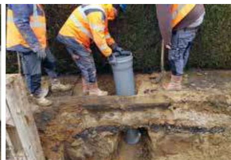
Travaux préparatoires pour la pose d'une boîte de branchement
