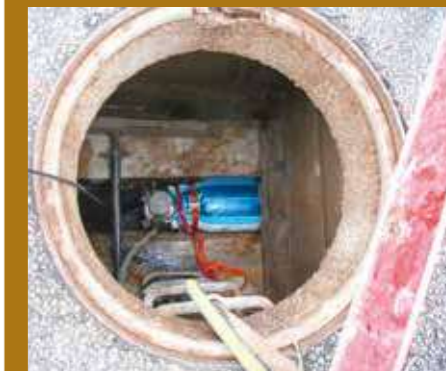
Gaine gonflée en cours de polymérisation
