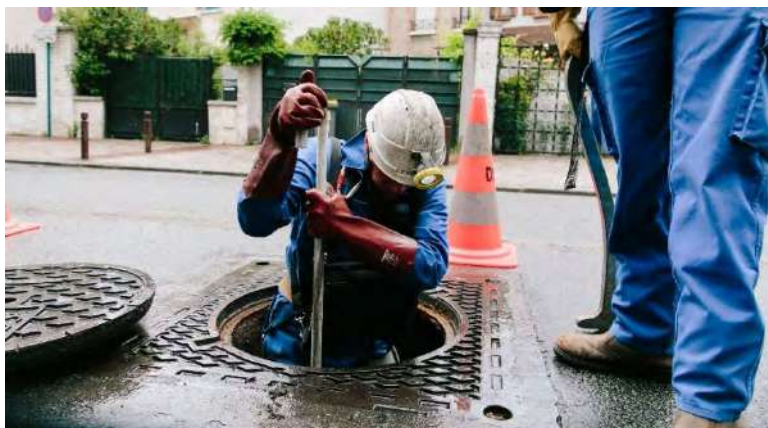
Descente en réseau - Photo DR
