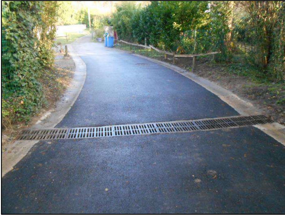
Figure 15 : Chemin du Moulin (hameau de Maincourt-sur-Yvette) à Dampierre-en-Yvelines - Réfection des enrobés
