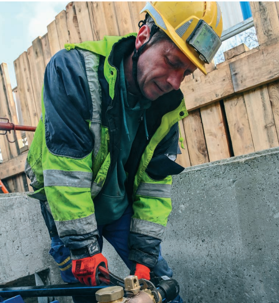
Environnement du chantier de la RN14 pour les JO 2024
