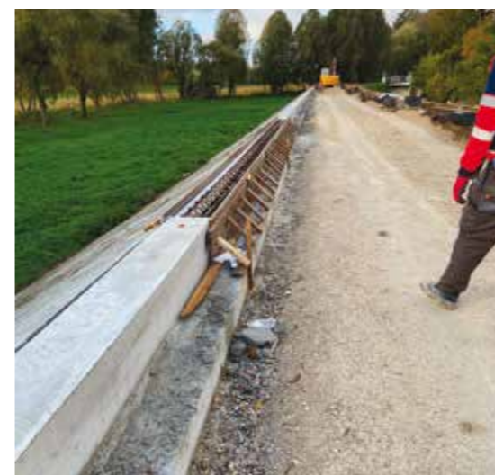
Longrine en béton du déversoir
