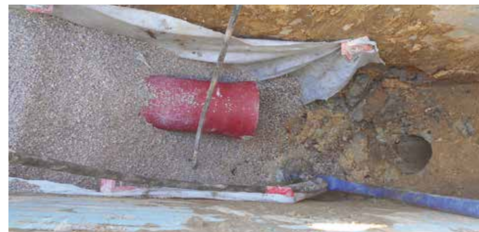
Remplacement de la canalisation existante par ouverture de tranchée
