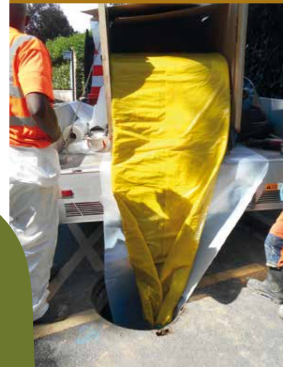
Introduction de la gaine pour le chemisage structurant du collecteur
