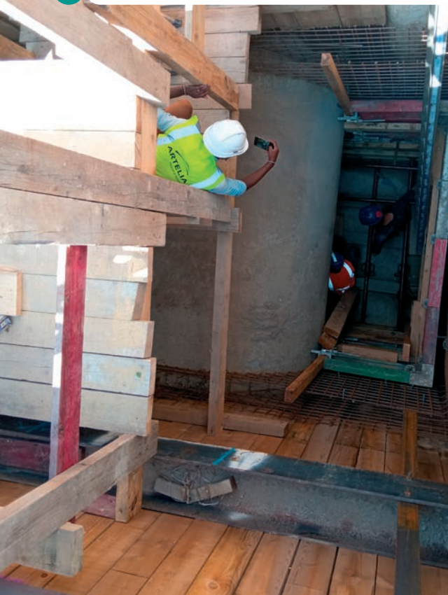
Création de la chambre de comptage autour de la canalisation DN 2000
