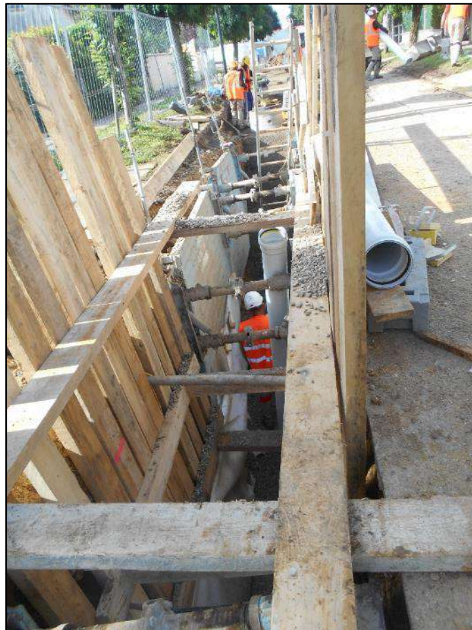
Figure 18 : Avenue de Sully au Mesnil-Saint-Denis - Pose de canalisation en polypropylène Ø200
