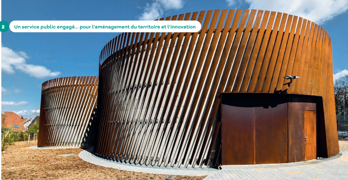
Station de pompage de Bruyères-de-Sèvres
