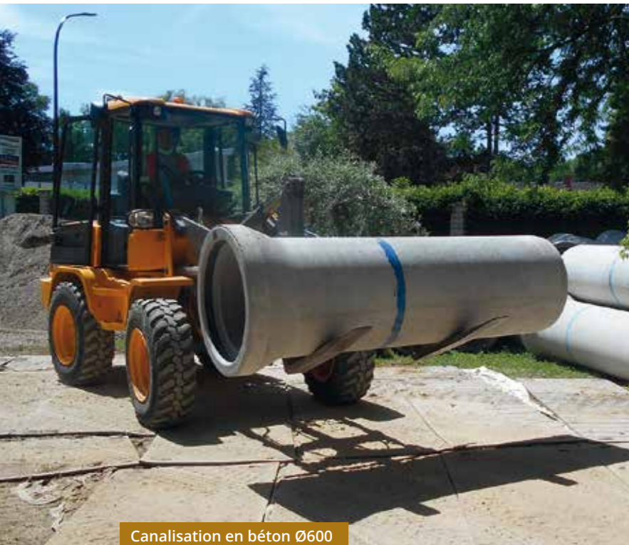
Canalisation en béton Ø600
