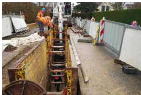
Travaux en tranchée ouverte (remplacement de canalisation)
