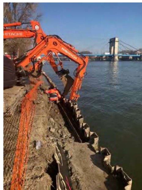
Poutre de couronnement quai Jules Guesde à Vitry-sur-Seine - ©Jean-Pierre Bultieau
