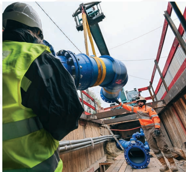
Chantier de performance réseau à Argenteuil
