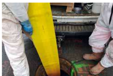
Travaux de chemisage - Introduction de la gaine dans un regard
