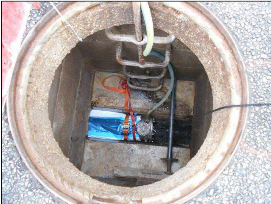
Figure 20: Boulevard Pasteur à Bures-sur-Yvette - Tractage de la gaine
