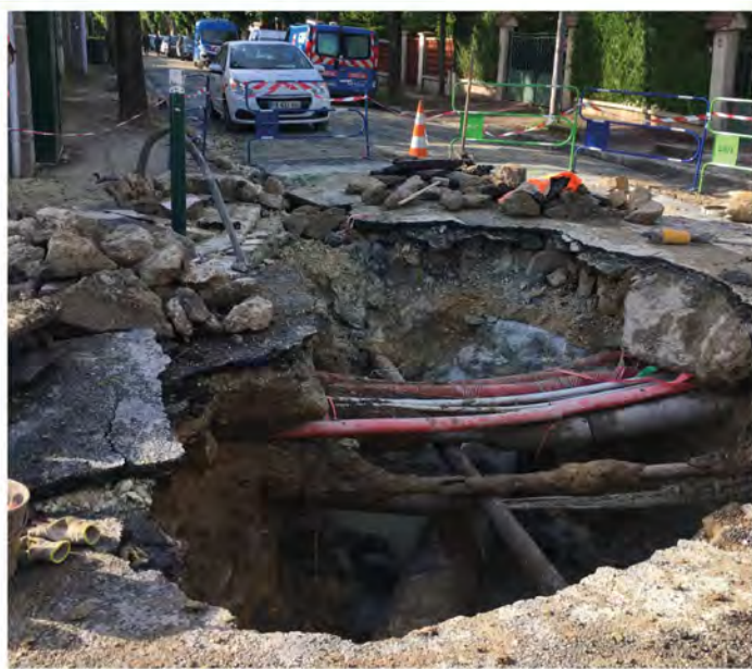
Sucy-en-Brie fuite 24 mai jour férié : importante et spectaculaire fuite sur le transport d'eau potable.
