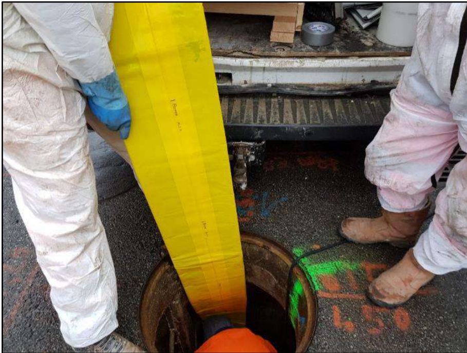
Figure 16 : Domaine de Montvoisin à Gometz-la-Ville - Introduction de la gaine dans un regard
