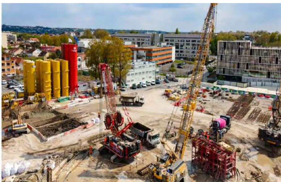
Atelier de parois moulées à la SDEP – avril 2021 ©entreprise SOLETANCHE BACHY
