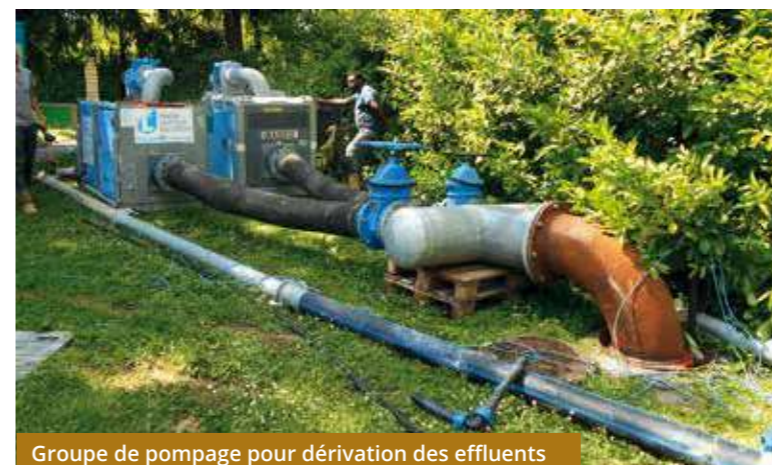
Pose de canalisation en béton par ouverture de tranchée
