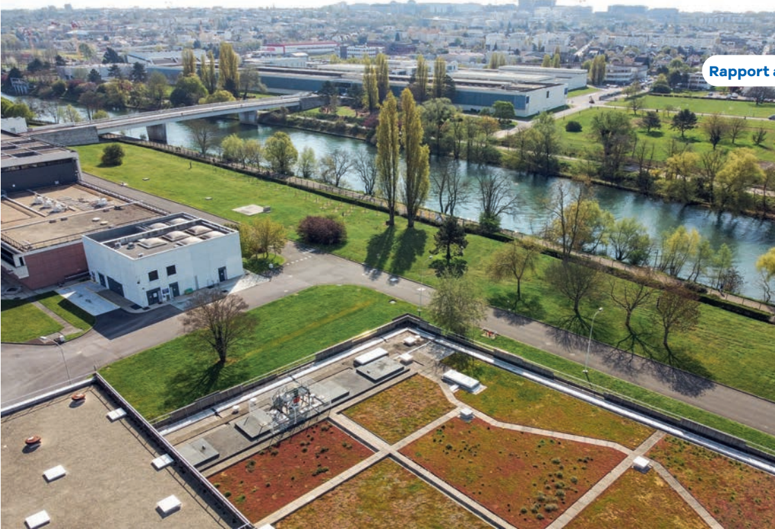
Vue aérienne de l'usine des eaux de Neuilly-sur-Marne
