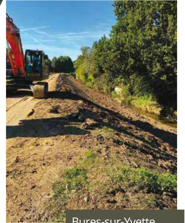
Bures-sur-Yvette Sécurisation du bassin de Bures - Gif
