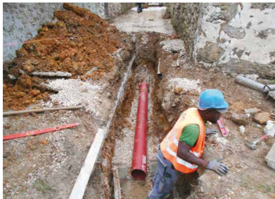
Création du réseau sous la partie publique Champ-Romery - Dampierre-en-Yvelines
