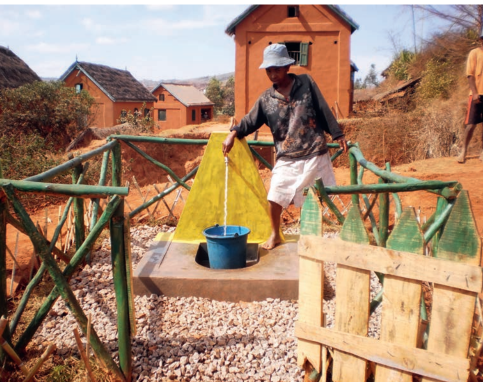
La borne fontaine fournit une eau propre à proximité du ménage, moyennant 2,5 euros par famille par an
