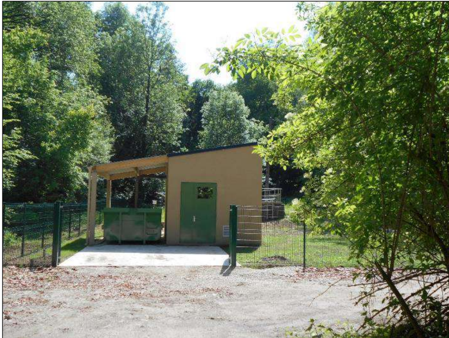
Figure 6 : Photo STEP de Boullay-les-Troux
